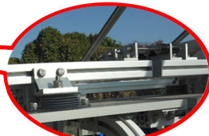
フレーム上部 防振ゲルと連結ダンパー
