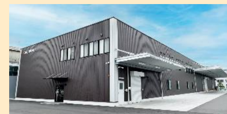
全面リニューアルした四日市事業所 (写真は倉庫兼事務所棟)
