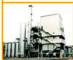
1964 大型 水素製造装置
