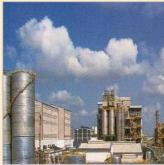
▶ ケミカルプラント建設
