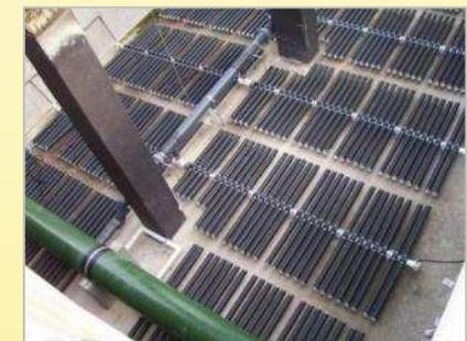
▶ 超微細気泡散気装置
