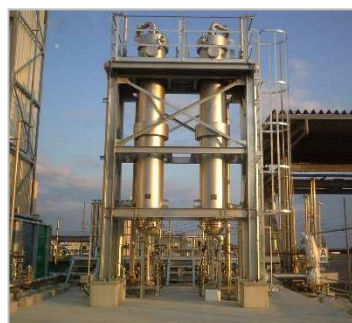
▶ 温水式LNG気化器
