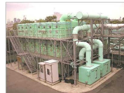
▶ 生物脱臭プロセス(充填式生物脱臭法)
