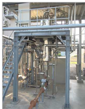
▶ 汚泥熱可溶化 消化装置
