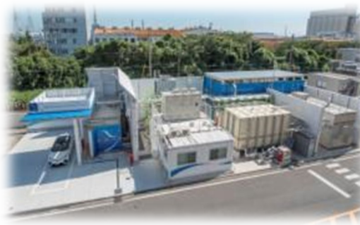
■ MKK川崎水素ステーション
