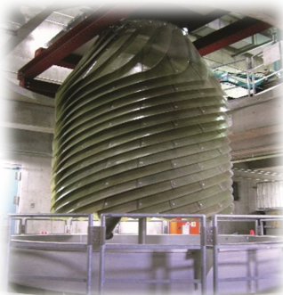
■ 超高速沈殿装置
