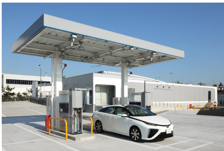
豊洲水素ステーション
