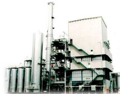
■ LNG気化器 (中間熱媒体式：OG-TRI-EX)
