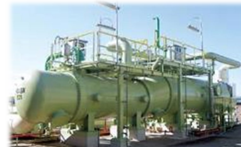
■ LNG気化器 (中間熱媒体式：OG-TRI-EX)
