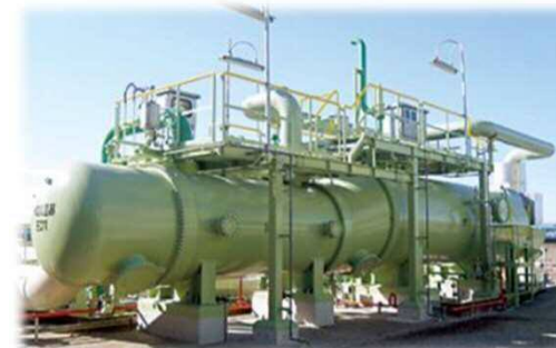
■ LNG気化器(中間熱媒体式:OG-TRI-EX)
