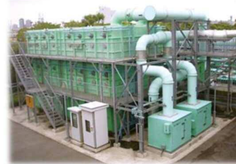
■ 生物脱臭プロセス(充填式生物脱臭法)
