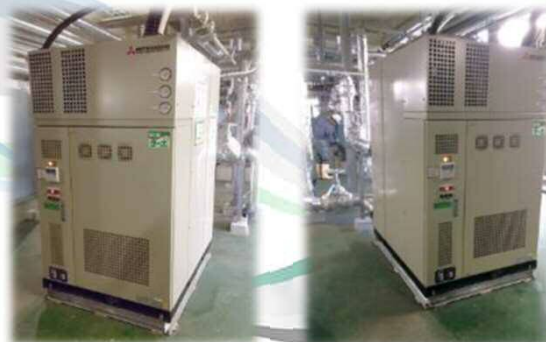
■ 消化槽の熱回収(ヒートポンプ)
