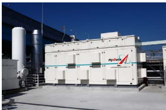
高性能小型オンサイト水素製造装置
