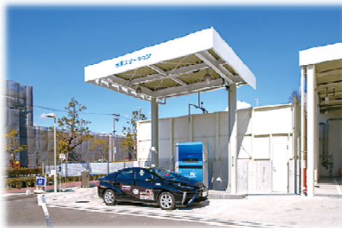
■ 水素ステーション
