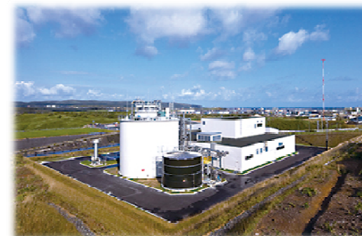
■ バイオガスシステム
