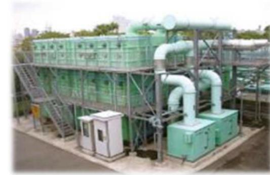
■ 超高速沈殿装置
