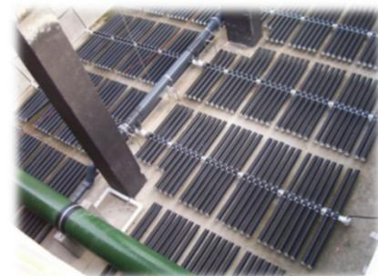
■ 消化槽の熱回収(ヒートポンプ)
