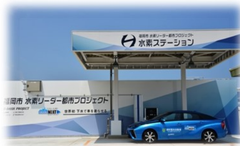
下水バイオガス水素ステーション 外観
