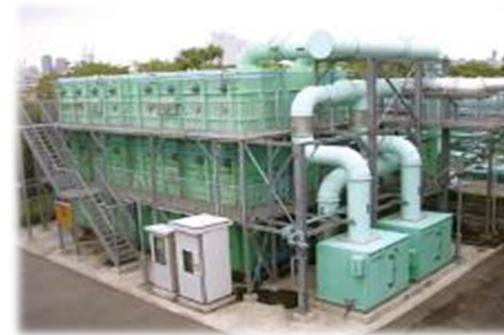
■ 超高速沈殿装置
