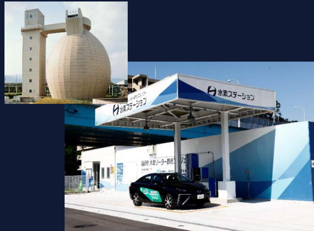
下水バイオガス原料による水素等創エ ネ技術 (左上:下水消化槽 右下:水素ステーション)
